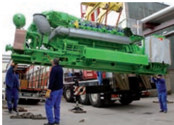
Anlieferung und Montage der Turbine
