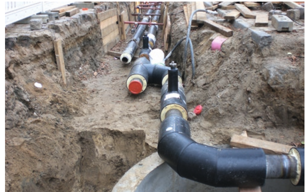
Verlegung von Fernwärmeleitungen in der Innenstadt
