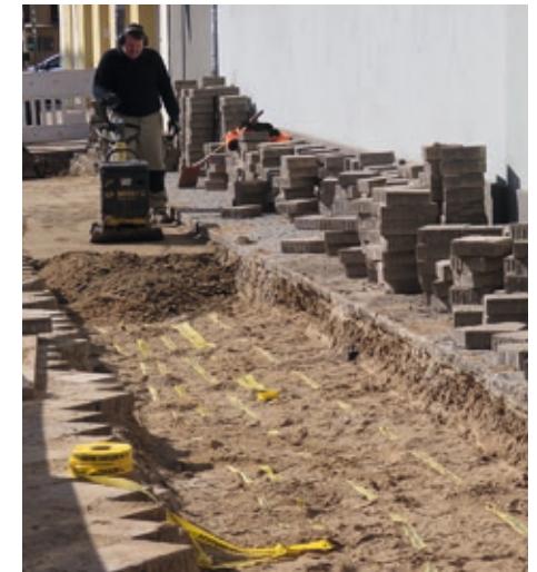
Auch nach Abschluss einer Baumaßnahme müssen wieder Warnbänder verlegt werden. Foto: SWS
