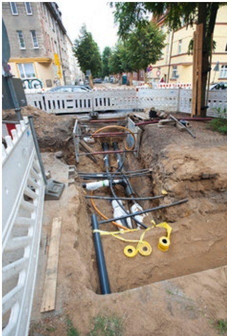
Herstellung von Hausanschlüssen
