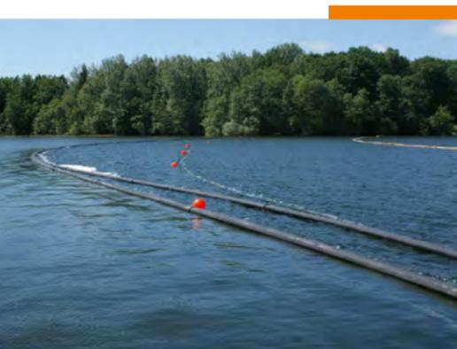
Seit mehr als 50 Jahren wird das Gewerbegebiet Sacktannen über zwei Mittelspannungskabel mit elektrischer Energie versorgt, die vom Umspannwerk in Lankow geliefert wird und geradewegs durch den Neumühler See verlaufen. Nun war altersbedingt die Erneuerung der Kabel erforderlich. Die besondere Herausforderung bestand in der Tatsache, dass der Neumühler See als direktes Einzugsgebiet für die Wassergewinnung gilt und deshalb ein Trinkwasserschutzgebiet ist.
