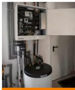
Eine Fernwärmestation im Durchlaufprinzip
