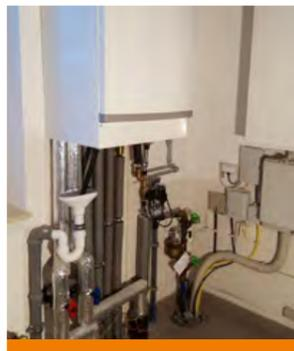
Eine Fernwärmestation mit Warmwasserspeicher
