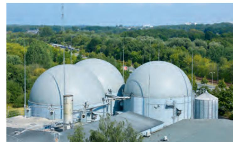
Die Biogasanlage in Schwerin wird mit 75 % Maissilage und 25 % Roggen-Ganzpflanzensilage (GPS) betrieben.
