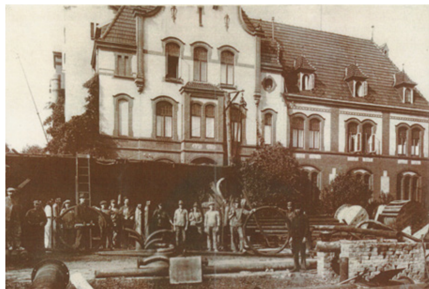
Einführung von Wärmeleitungsrohren am Pfaffenteich, 1924
