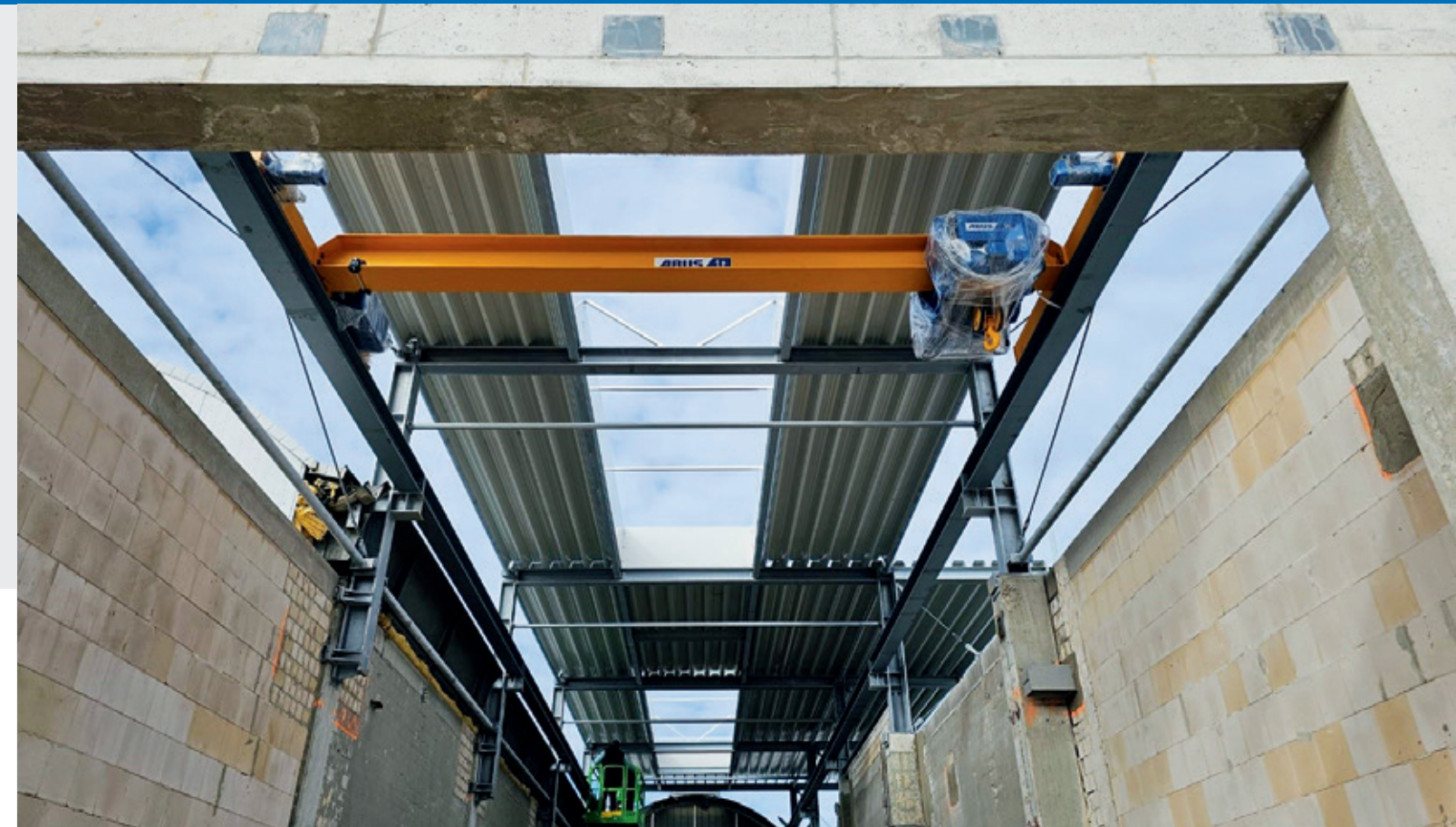
Die Stahlstützenkonstruktion ist fertiggestellt, die Krananlage installiert (18.03.2024).
