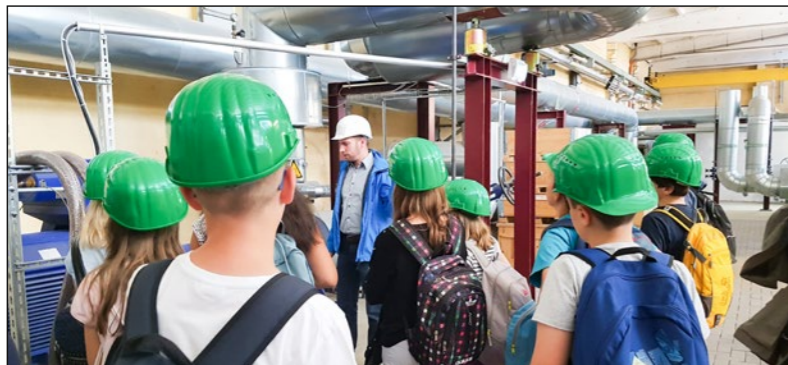
Wie Fernwärme funktioniert, konnten sich Schüler im Heizkraftwerk ansehen Foto: SWS
