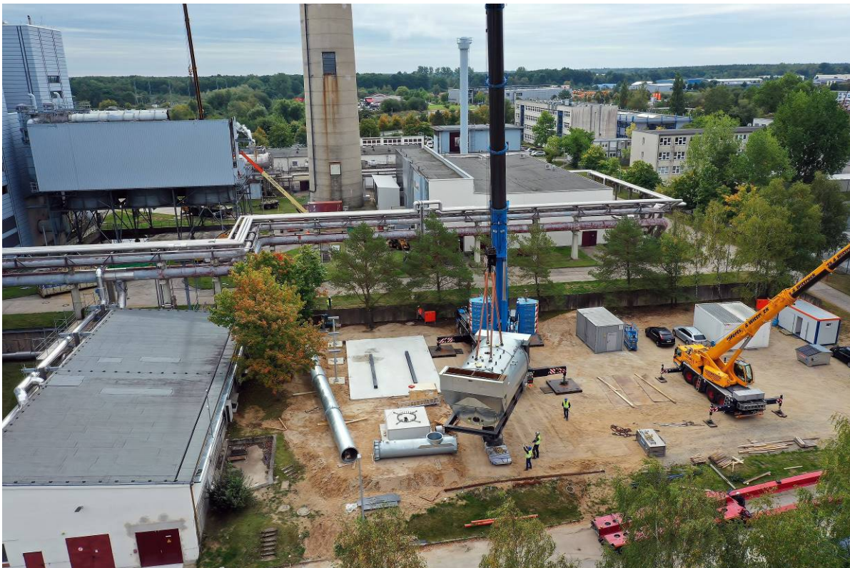
Der 135 Tonnen schwere Kessel kann nur von einem speziellen Autokran angehoben werden.
