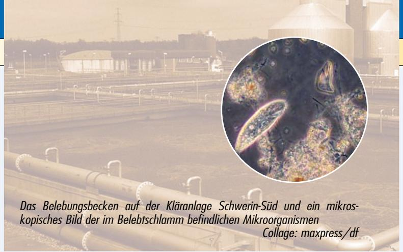
Das Belebungsbecken auf der Kläranlage Schwerin-Süd und ein mikroskopisches Bild der im Belebtschlamm befindlichen Mikroorganismen
