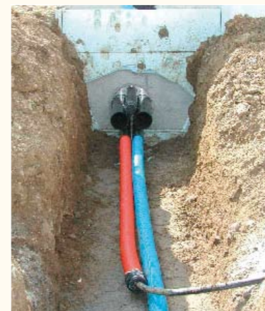
Alle nötigen Anschlüsse werden an einer Stelle durch die Wand geführt
