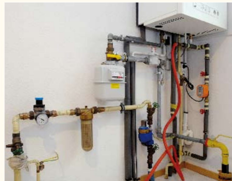
Die wesentlich platzsparenderen Lösungen der Mehrspartenhausanschlüsse sorgen für mehr Übersichtlichkeit und Flexibilität
