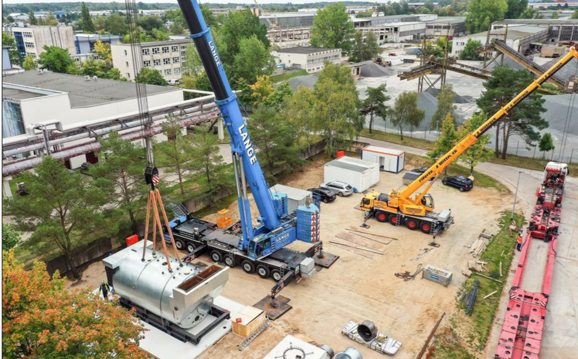
Nach knapp vier Stunden und einer Umpositionierung des Spezialkrans ist der Mietkessel sicher auf seinem Fundament platziert
